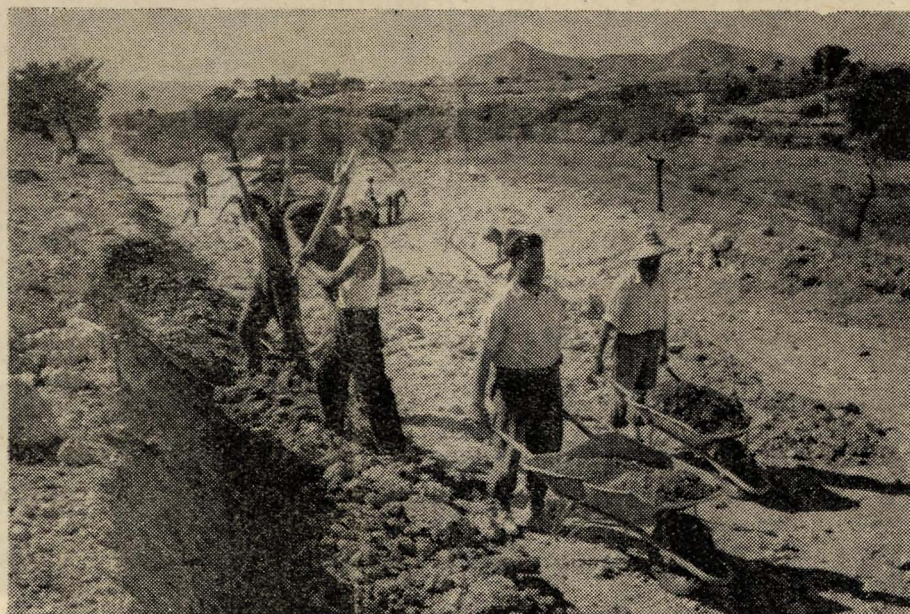
Trabajos en la carretera de desviación. Año 1959. Noviembre (Foto Simeón)
