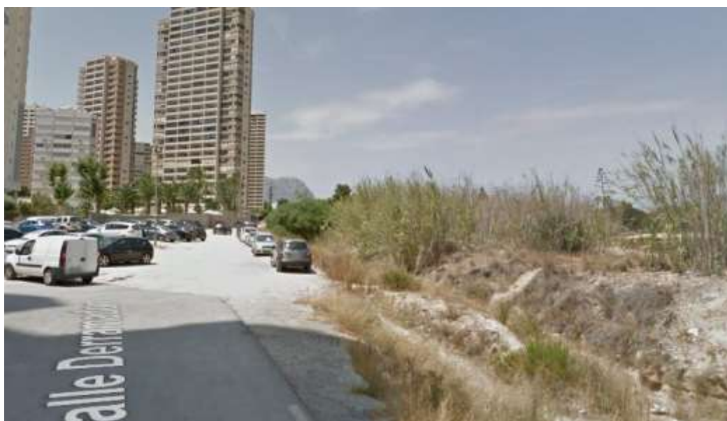
Detalle de la calle Derramador y su linde con el cauce del Barranco, desde la zona sur Fuente: Google Maps
