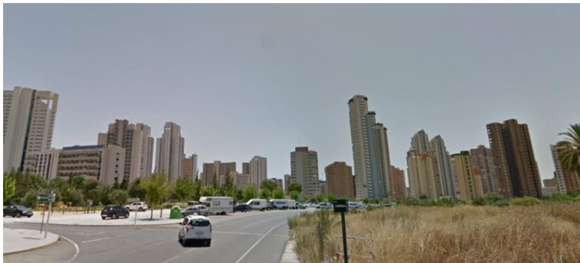
Ilustración 3 Avenida de la Carretera del Albir vista desde su entronque con el camino de Armanello, dejando a la izquierda el sector
