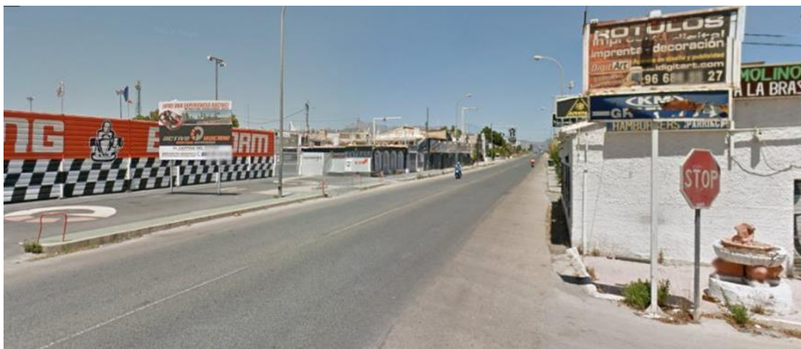
Ilustración 3 Avenida de la Comunidad Valenciana (antigua CN-332) en su confluencia con el camino del Azagador de Soria. Puede apreciarse la bandeja de instalaciones de ocio nocturno que la jalonan por ambos sentidos.
