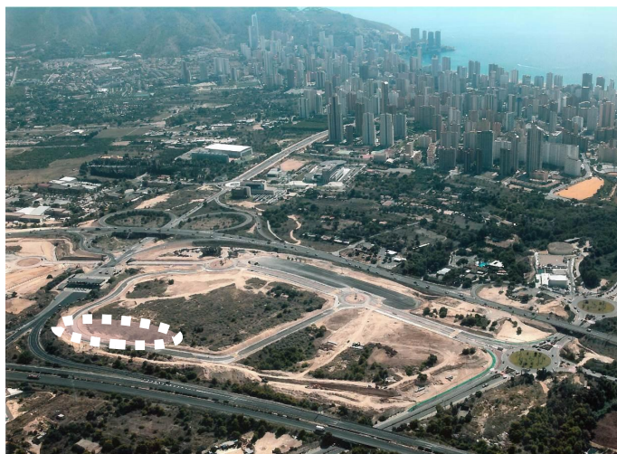
Localización de Centro de Transformación y torres de alta tensión
