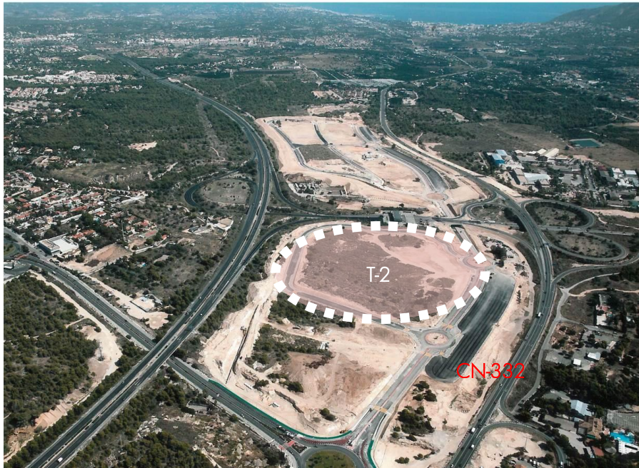
Vista aérea Suroeste
