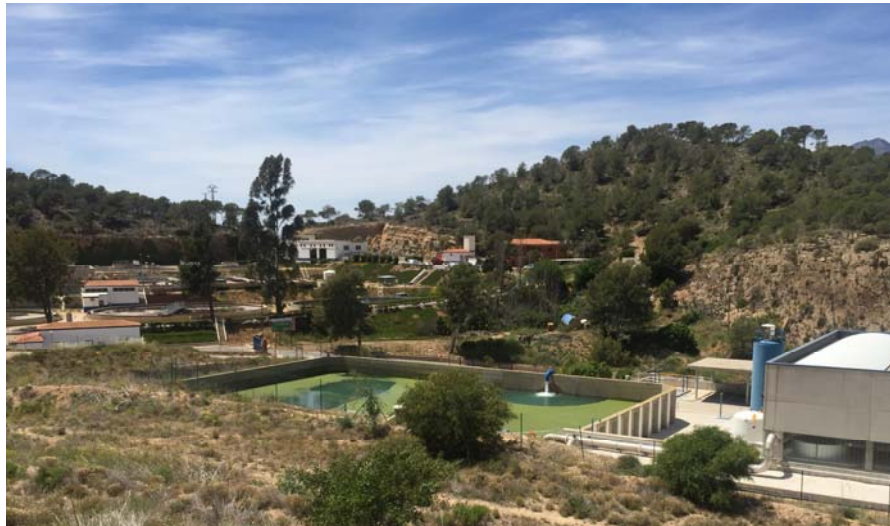
Figura 28. Balsas de la depuradora en Serra Gelada. Fuente: elaboración propia.
