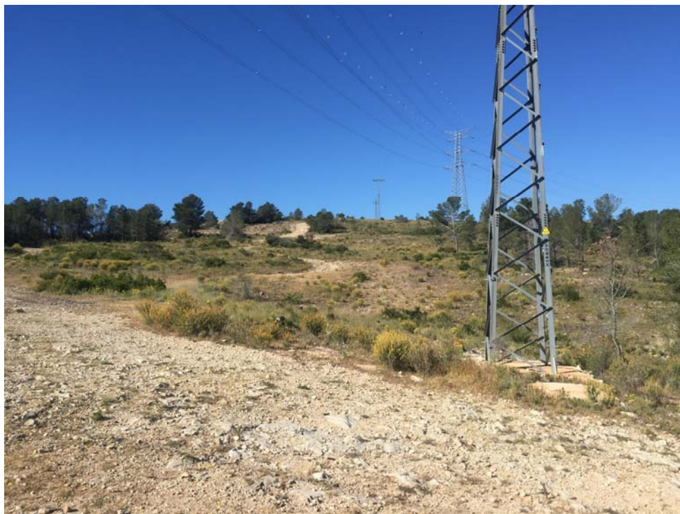
Figura 18. Línea eléctrica en el término municipal de Benidorm. Fuente: elaboración propia.
