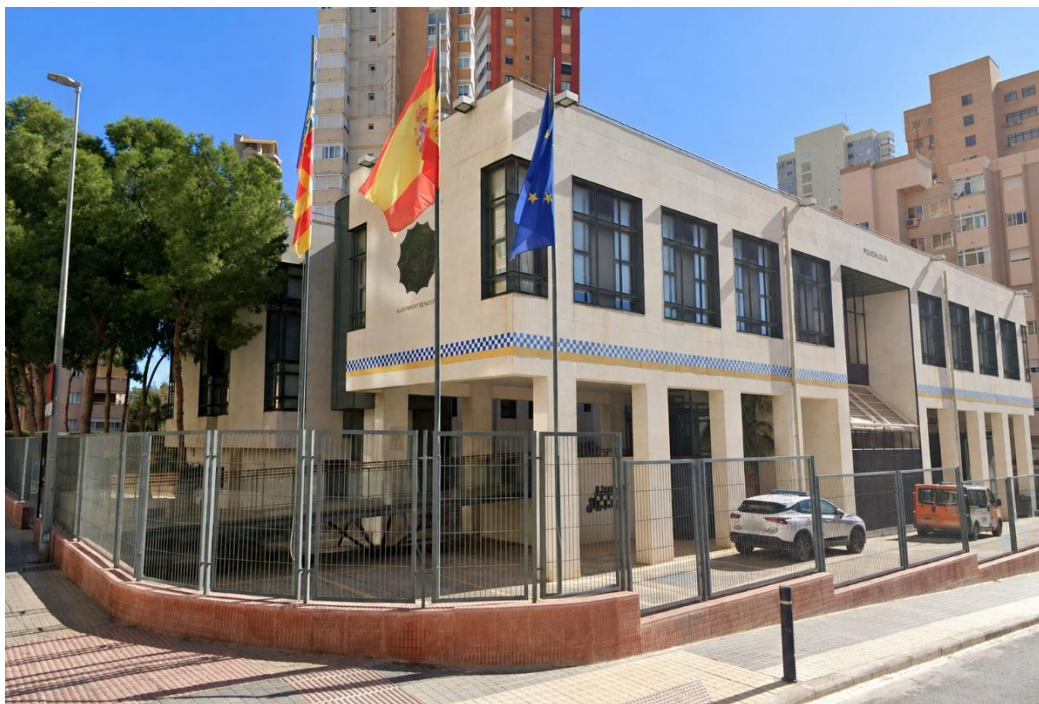
Figura 8. Fachada instalaciones Policía Local.
