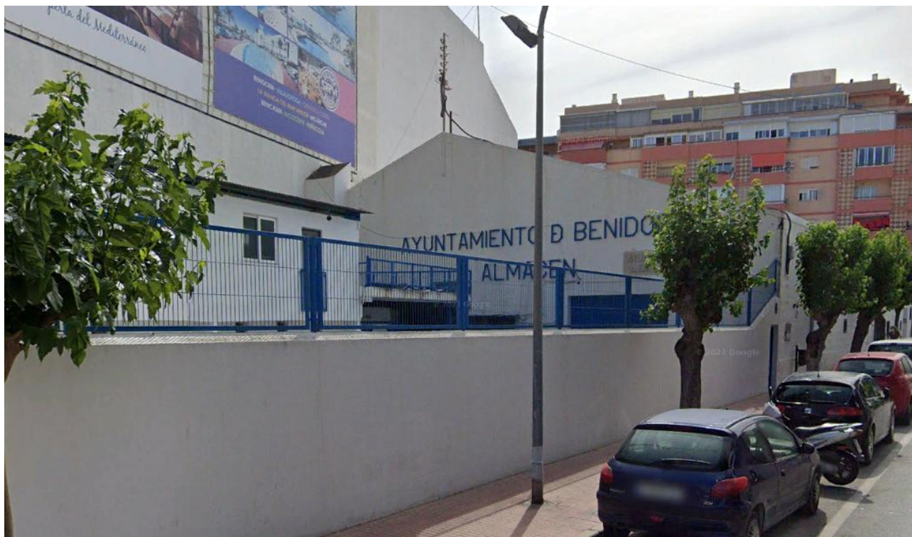
Figura 10. Fachada instalaciones del Almacén Municipal.
